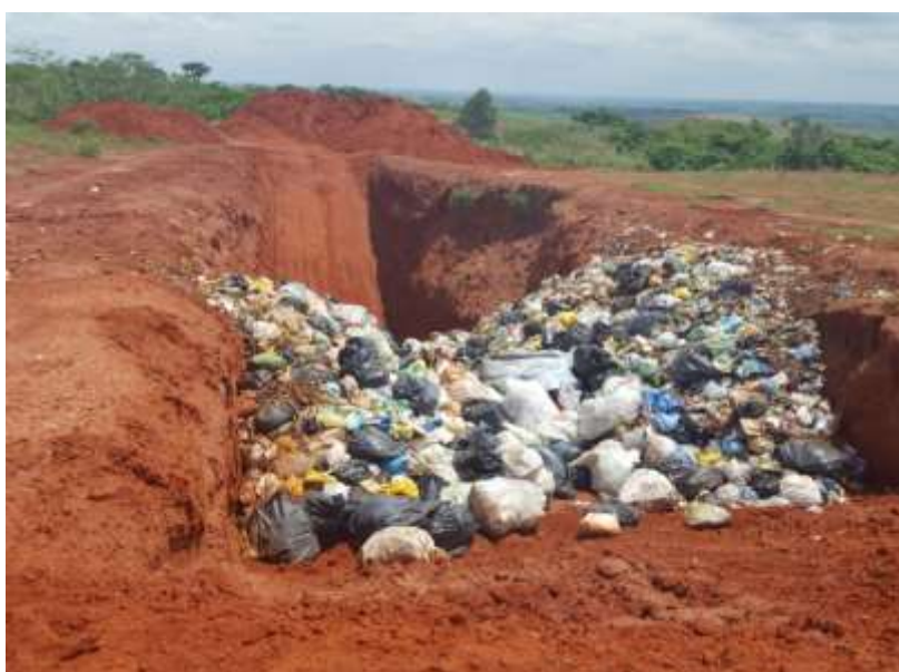
Figura 2. Resíduos depositados na vala sem recobrimento adequado e ausência de drenagem superficial
